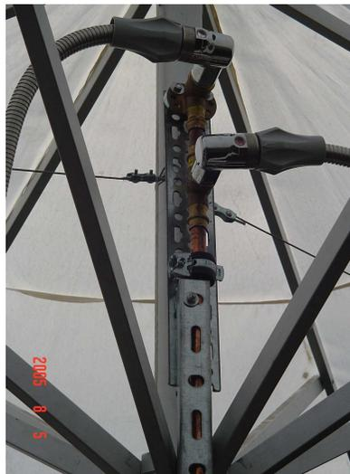
Der Übergang von den Zuleitungen zum Anschlussverteiler am Fuß des Sonnenschirmes erfolgt über flexible Leitungen. Der Anschluss der Strahler erfolgt über flexible Leitungen, die mit Steckern für die handelsüblichen Gas- und Elektrosteckdosen ausgerüstet sind.
