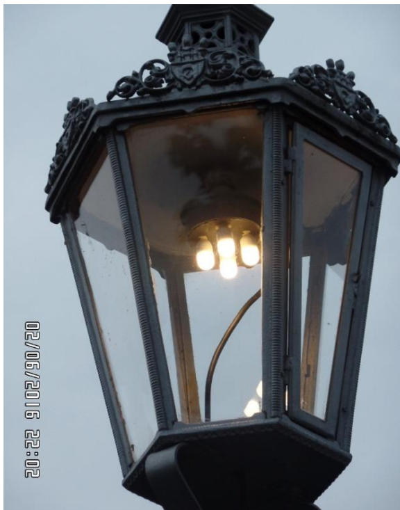
Bild 3: Im Biergarten „Schillergarten“ mit „IBAP Leuchtmittelträger“ – Einschaltet – 4 x 1,5 Watt LED
